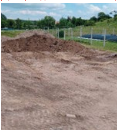
příprava plochy pro další odvodňovací vaky
